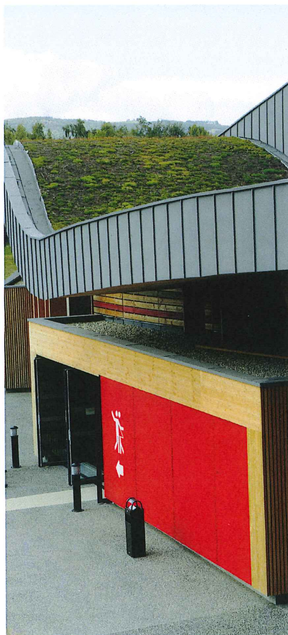
Toiture végétalisée du Pôle festif et sportif de Saint-Jean-Bonnefonds
