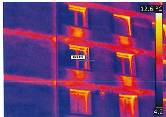
Thermographie d'une façade d'immeuble
