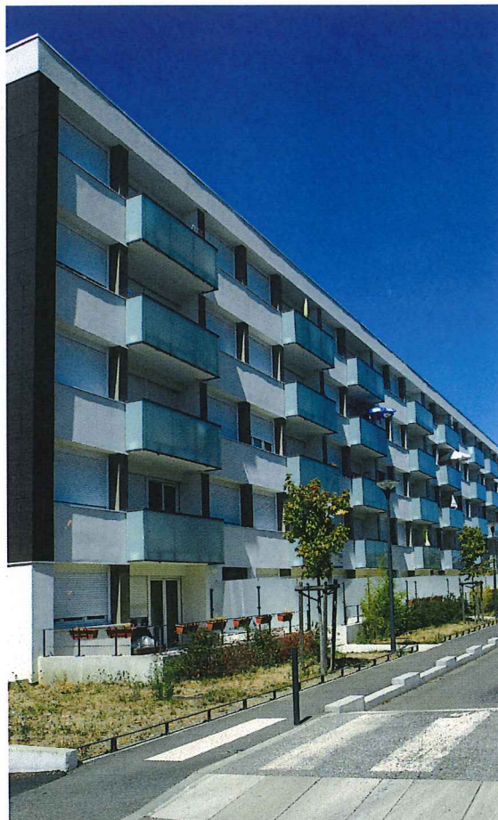
Habitat social à Rive-de-Gier (quartier du Grand Pont). Réhabilitation thermique BBC
