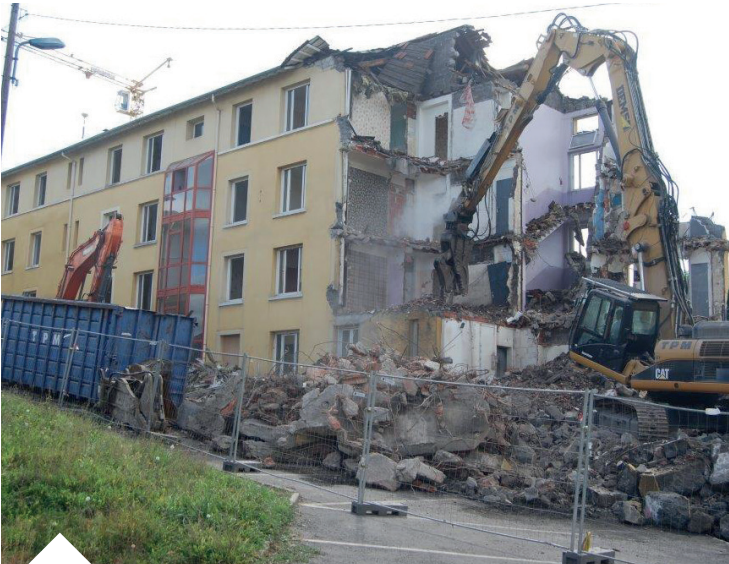
Démolition bâtir et loger
