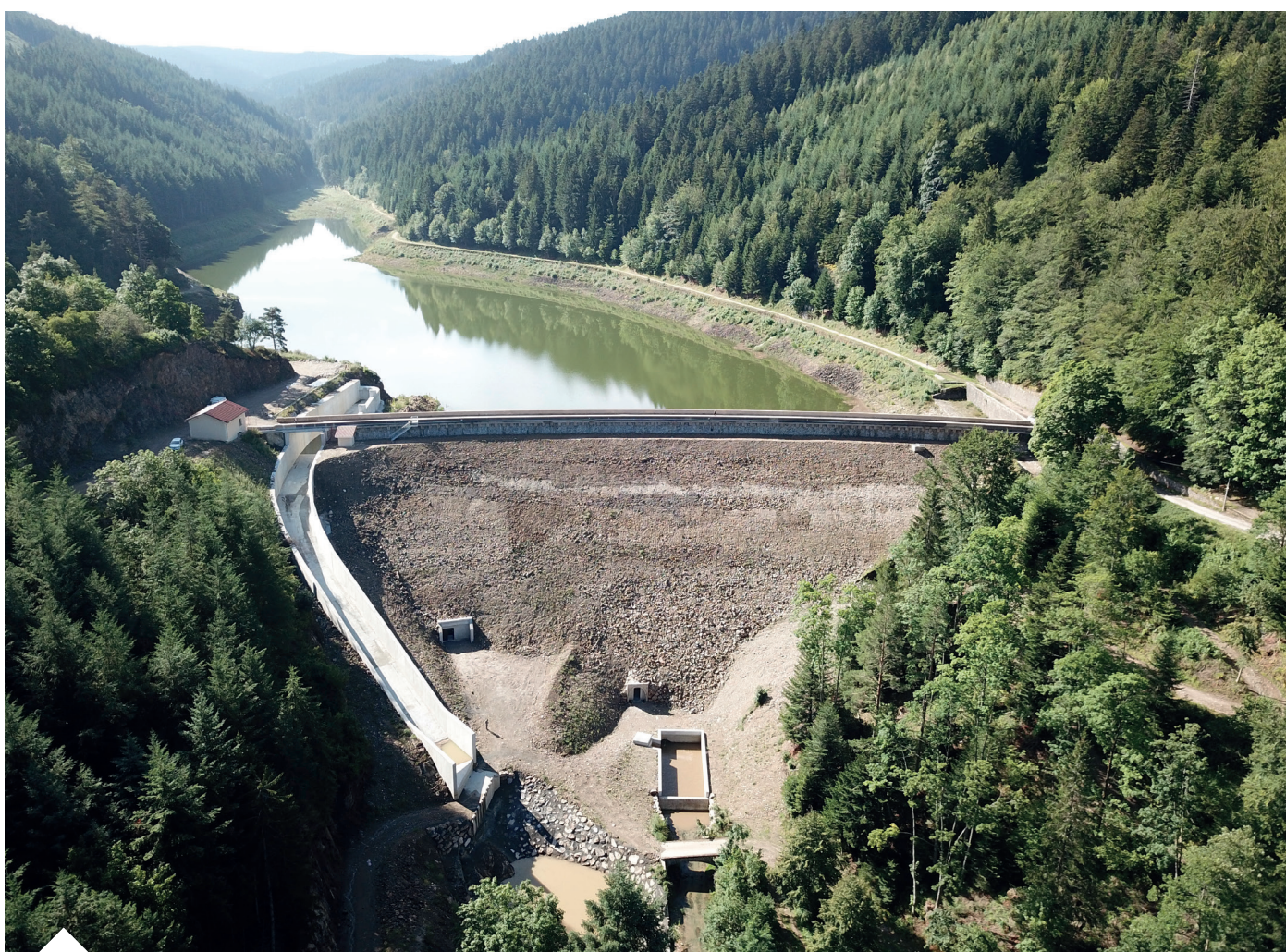
Barrage du Pas-de-Riot
