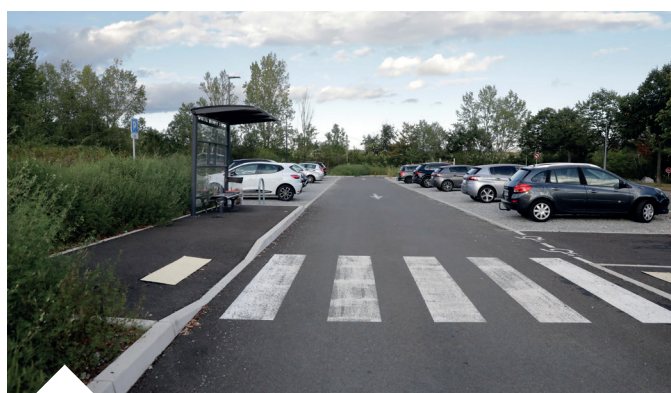
Parking de covoiturage - Aire du Pays du Gier
