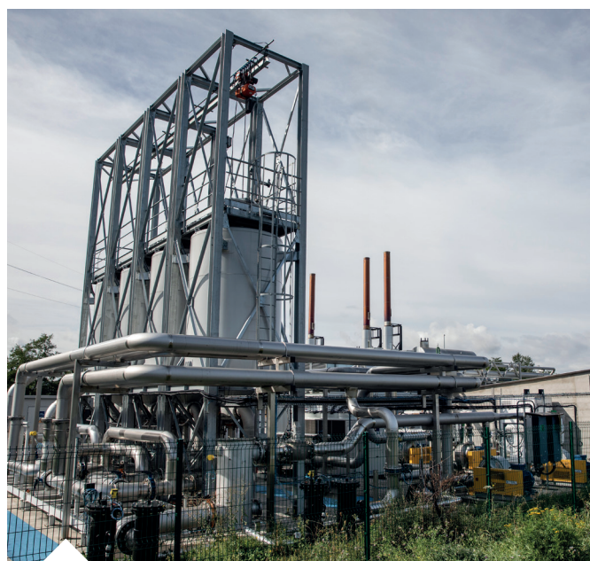
Centre de stockage des déchets borde matin
