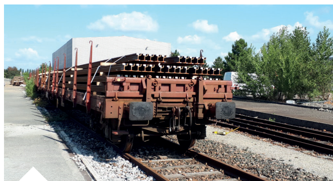
Approvisionnement des rails de la 3 e ligne par la SNCF
