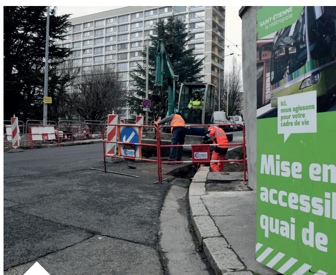
Mise en accessibilité du quai de bus Valbenoîte
