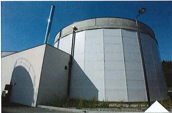
© Assainissement et rivières – Méthaniseur, station d'épuration de Furania Source : Assainissement et rivières, SEM
