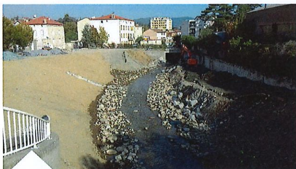
© Assainissement des rivières – Découverte du Gier Source : Assainissement des rivières, SEM
