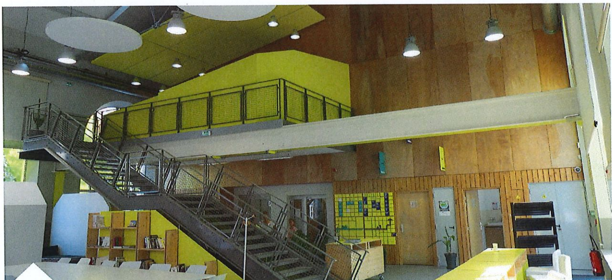
© Brun Pierre - Direction développement Durable et Energies - SEM - En jaune, baffles absorbantes. Source : Direction développement Durable et Energies, SEM
