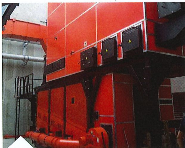
© Direction Développement Durable et Energies – Travaux de construction d'une 2 ème chaudière bois et d'une cogénération au réseau de Châteaueux. Source : Direction Développement Durable et Energies, SEM
