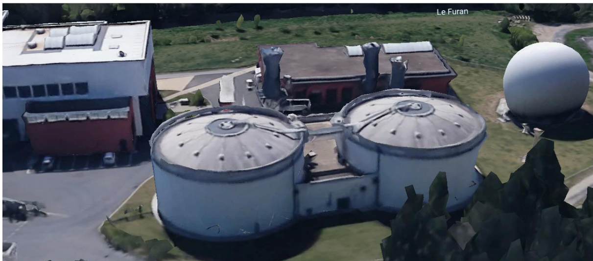
Figure 3 : Vue aérienne des deux digesteurs de 4500 m 3 unitaire de FURANIA
