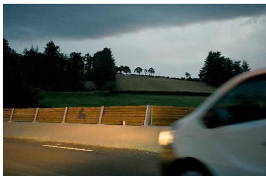
Saint-Genest-Lerpt : La Métropole a réalisé des travaux de protection de la faune pour éviter la traversée de la RM 201 du lieu-dit "La réardière" sur un linéaire de 205 ml des 2 côtés. Ces installations ont été conçues pour limiter les écrasements d'espèces et éviter les collisions avec les automobilistes.
